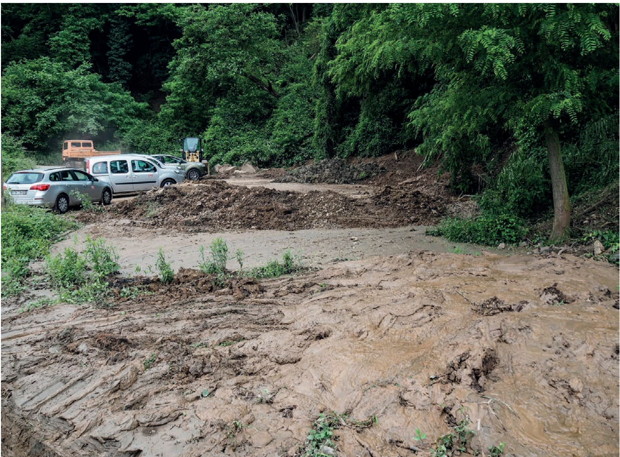
Abb. 4: Situation am Fuß des Tals (4). Hier haben sich breitflächig Erosionsmassen verteilt, die allerdings nicht bis zur Bahnstrecke und Bundesstraße reichten (Foto: A. WEHINGER, 28.06.2016).
