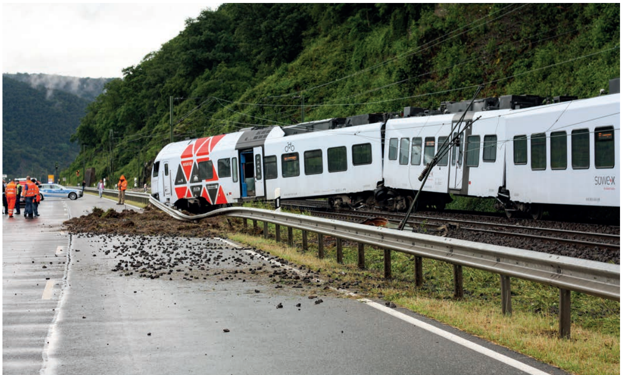
Abb. 7: Entgleister Zug in Folge eines starkregeninduzierten Murgangs am 25.06.2016 bei Bacharach (Foto: R. KIRCHHOFF, 25.06.2016).
