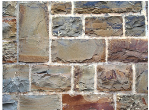
Grauwackensockelmauerwerk eines Wohnhauses in Gummersbach (Foto: W. Reimer)
