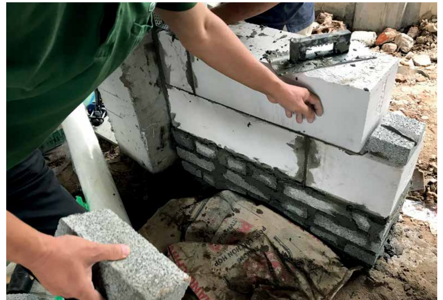
Hình 6.1. Triển khai xây dựng tòa nhà thí nghiệm của Viện Nghiên cứu Vật liệu Xây dựng Việt Nam (VIBM) tại Hà Nội (Nguồn: Andreas Zegowitz)
