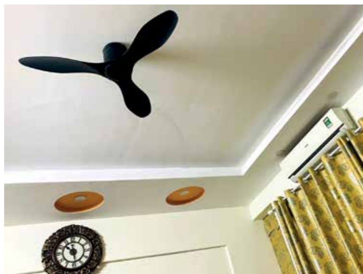
Hình 8.6. Tiết kiệm năng lượng bằng cách sử dụng quạt trần kết hợp với máy điều hòa (Nguồn: Nguyễn Hương Lan)
