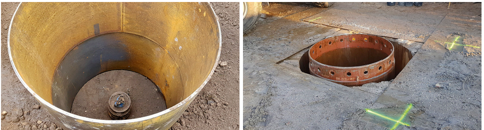
Abb. 9: Ansatz der Stand- (Bild links) und Überbohrrotour (Bild rechts) über dem Kopfroh des rückverfüllten Altbrunnens 2. Im Bild links sind eine spätere Stahl-Einschubverrohrung im ursprünglichen Graugussrohrausbau und das Peilrohr in der Kiesschüttung erkennbar (Fotos: C. Treskatis).
