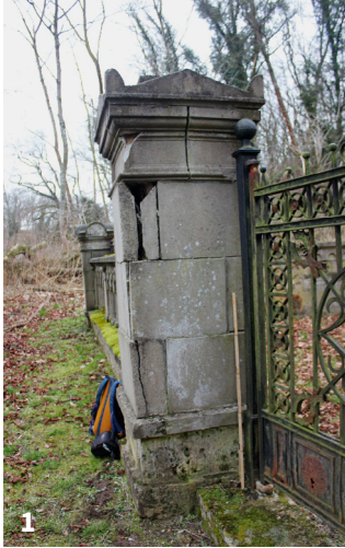
Abb. 1: Einer der stark geschädigten Eckpfeiler vor den Restaurierungsarbeiten
