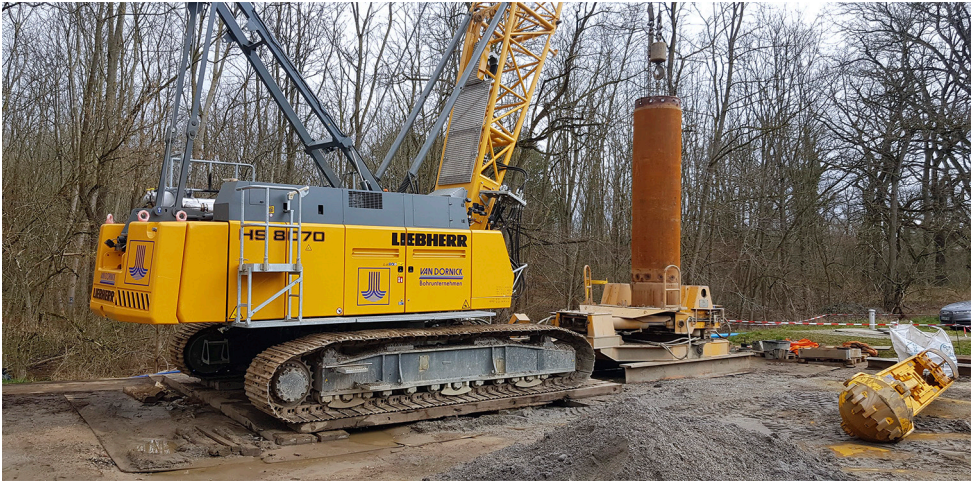
Abb. 10: Bohrgerät und Ansatz einer neuen Bohrrtour (Foto: C. Treskatis)
