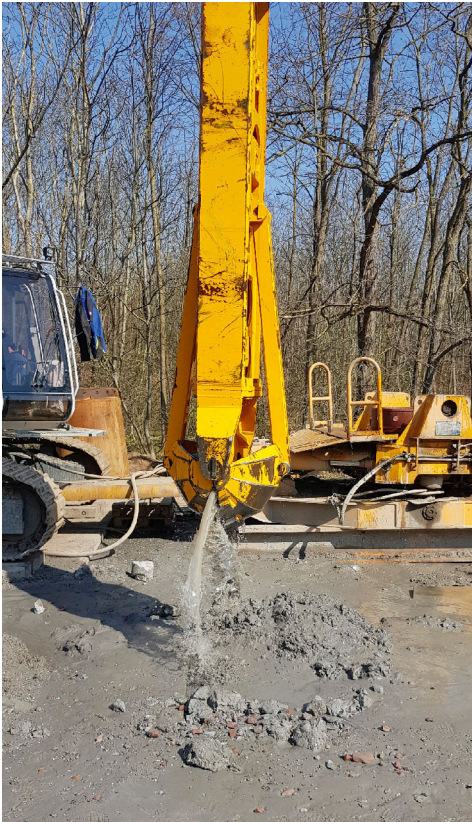
Abb. 11: Kugelgreifer zur Bohrgutbergung in der Bohrrtour (linkes Bild) und Bruchstücke des Gussrohrausbaus (rechtes Bild) sowie Reste der Stahlinschubverrohrung (Fotos: C. Treskatis)
