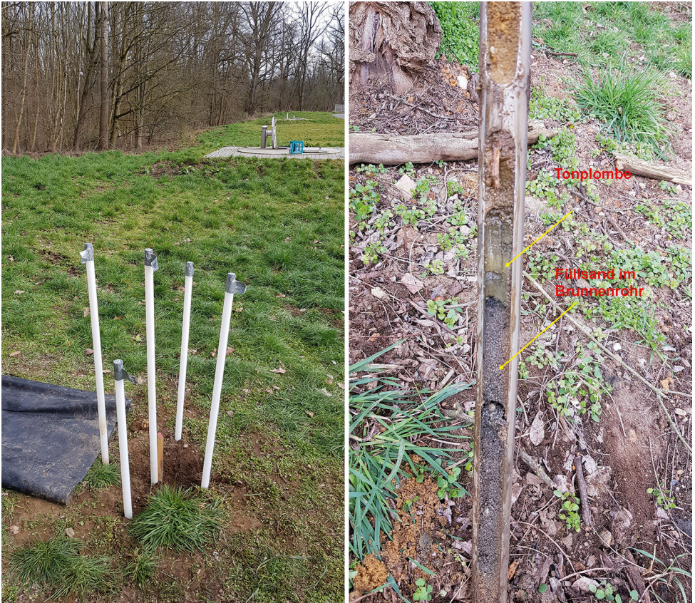
Abb. 7: Aufsuchungssondierungen mit Sondierprofil im Bereich des Brunnenkopfs des Altbrunnens 1. Im Hintergrund des linken Bildes befindet sich ein von den Salzwasseraufstiegen betroffener Ersatzneubaubrunnen (Fotos: C. Treskatis).
