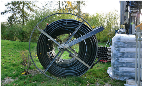
Abb. 1: Erdwärmesonde auf Haspel vor Einbau (Foto: S. Rumohr)
