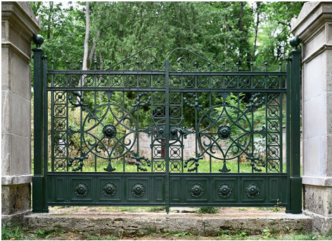
Abb. 1: Restauriertes schmiedeeisernes Haupttor und wiederhergestellte Torpfeiler (Foto: F. Pohlmann, Restaurator)
