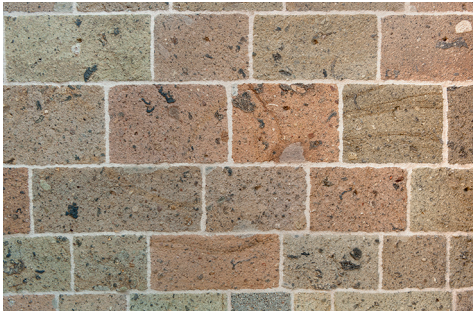
Die Farbenvielfalt des Suevits an der Pfarrkirche St. Salvator in Nördlingen. Gut zu sehen sind die dunklen „Flädle“, die glasigen Gesteinsschlieren (Foto: J.-M. Lange).
