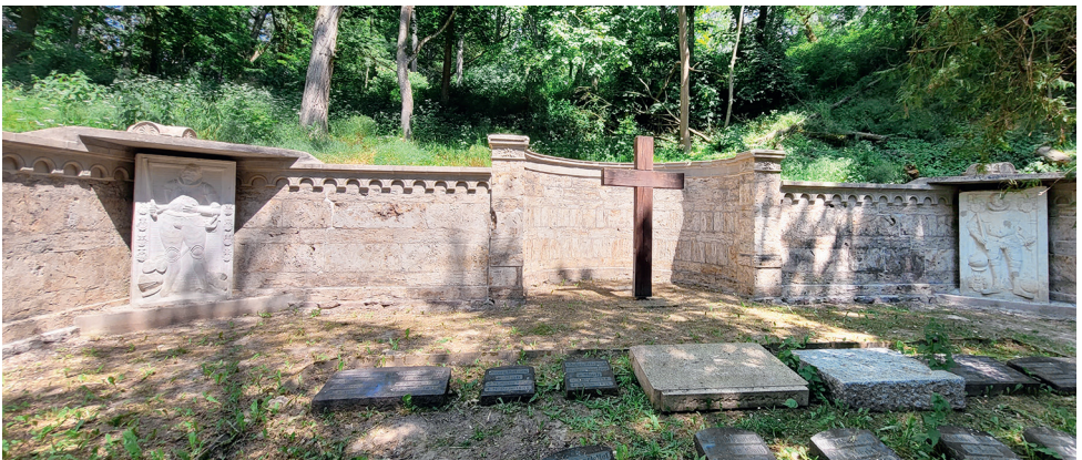
Abb. 2: Gereinigtes und wiederhergestelltes Natursteinmauerwerk aus Travertin (Foto: H.-G. Röhling)
