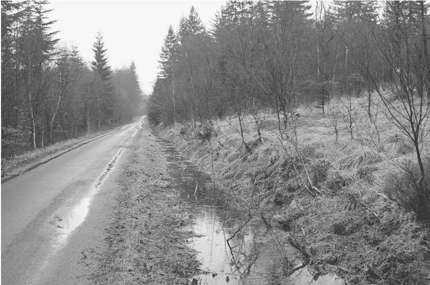
Abb. 3: Entwässerung durch Erschließung talseits des Schockelbruches Down-hill drainage of the Schockelbruch
