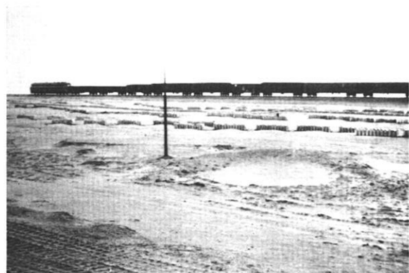
Abb. 11: Bahnstrecke mit aus Sandsäcken errichteten Schutzzäunen gegen Sanddrift an der Strecke Golmud-Xining im nördlichen Qaidam-Becken. (Aufn.: Jäkel, 9.9.1986)
