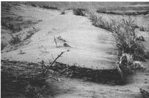
Abb. 6: Reisig- und Flechtzaun zur Dünenfixierung in Shapatou (Aufn.: Jäkel, 29.8.1986)
