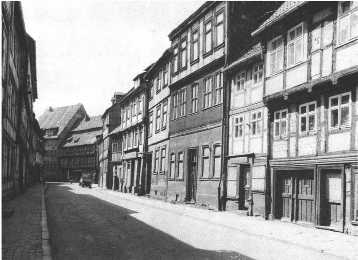
Abb. 4: Bebauung in der Bakenstraße (Foto: Verfasser, April 1988)
