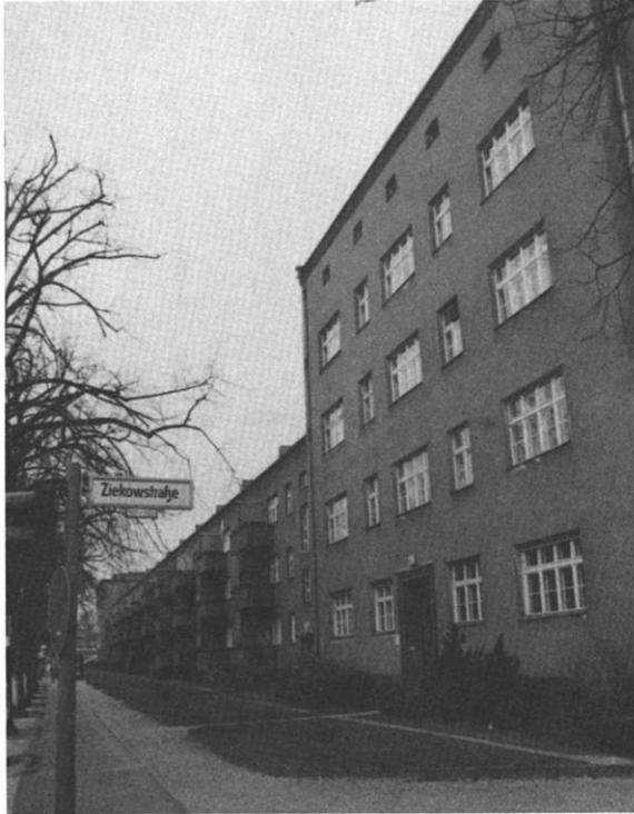
Abb. 2: Front zur Gorkistraße (Foto: Verfasser, März 1989). Im Vordergrund ein Teil der viergeschossigen Querseite eines Blockes, im Mittelgrund die dreigeschossige Längsseite mit Südbalkonen zur Gorkistraße.
