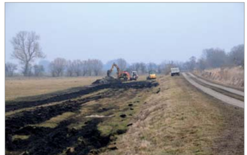
Abb. 25: Neubau der Drainage westlich Beesenberg (März 2013) Reconstruction of drainage west of Beesenberg (March 2013)
