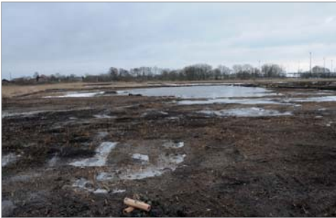
Abb. 16: Fertiggestellte Abtorfungsfläche 2 (FA-2) im April 2013 (im Vordergrund zerstörte Dränage) Completed peat stripping area 2 (FA-2) in April 2013 (destroyed drains in the foreground)
