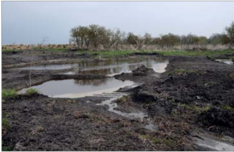
Abb. 20: Verwallungen mit Überlauf im Graben 21.027 (Mai 2013) Dams with overflow in ditch 21.027 (May 2013)
