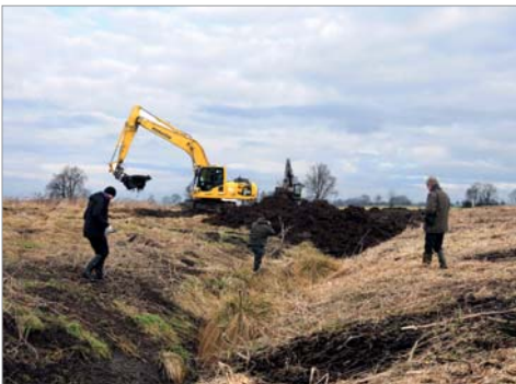
Abb. 12: Schwere Technik zum Verschluss der Gräben Heavy equipment to block the ditches
