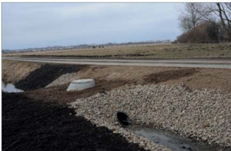
Abb. 24: Instandsetzung von Graben B, Bau einer Sohlschwelle und Schachtneubau (April 2014) Repairs to ditch B, construction of a bed barrier and reconstruction of a shaft (April 2014)
