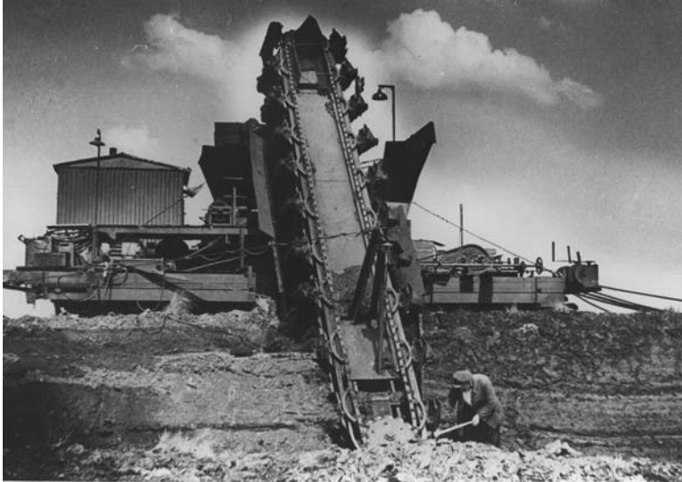
Abb. 6: Torfbagger System Wieland, Heseper Torfwerk, um 1930, Emsland Moormuseum, Fotoarchiv. Wieland peat bagger system. Heseper Torfwerk around 1930. Emsland Moormuseum, photograph archive.
