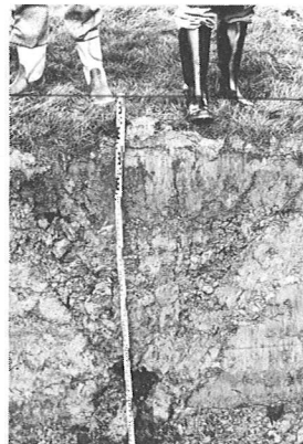
Bild 9.14 Arbeit der grabenfreien Dränmaschine mit Y-förmigen Schar von Fa. Hydro-mak; links angehobener Bodenkeil, rechts 1,2 m tief verlegter Rohrdrän mit gelockertem Bodenkeil darüber (Marschboden)
