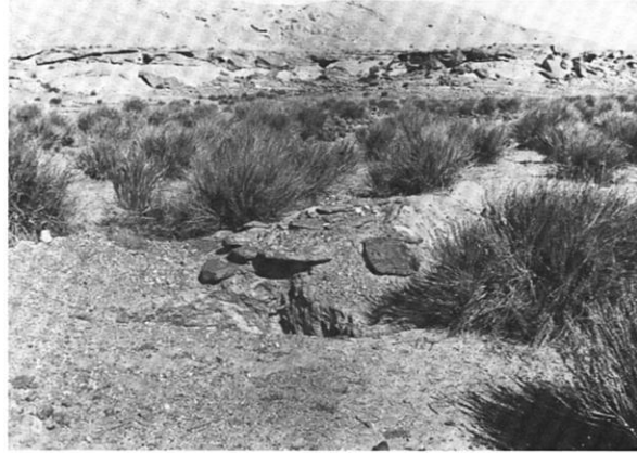
Photo 8: Eingestürzter Brunnen auf ehemaligem Gartenland. Der als Loch sichtbare einstige Brunnenschacht ist von Aushubmaterial und verfallenen Steinpackungen umgeben.
