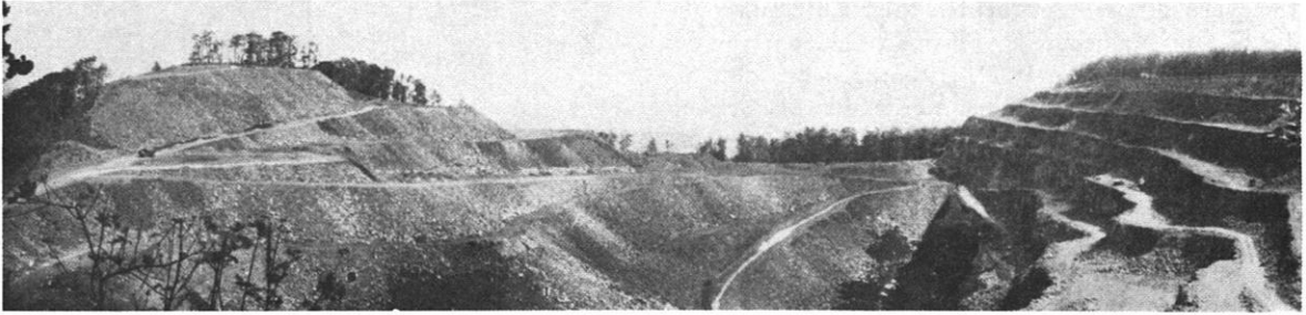
Abb. 3: Der Innenkippenbereich im Jahre 1969 nach Anlage der Bermen (aus: SCHADE 1976:99).
