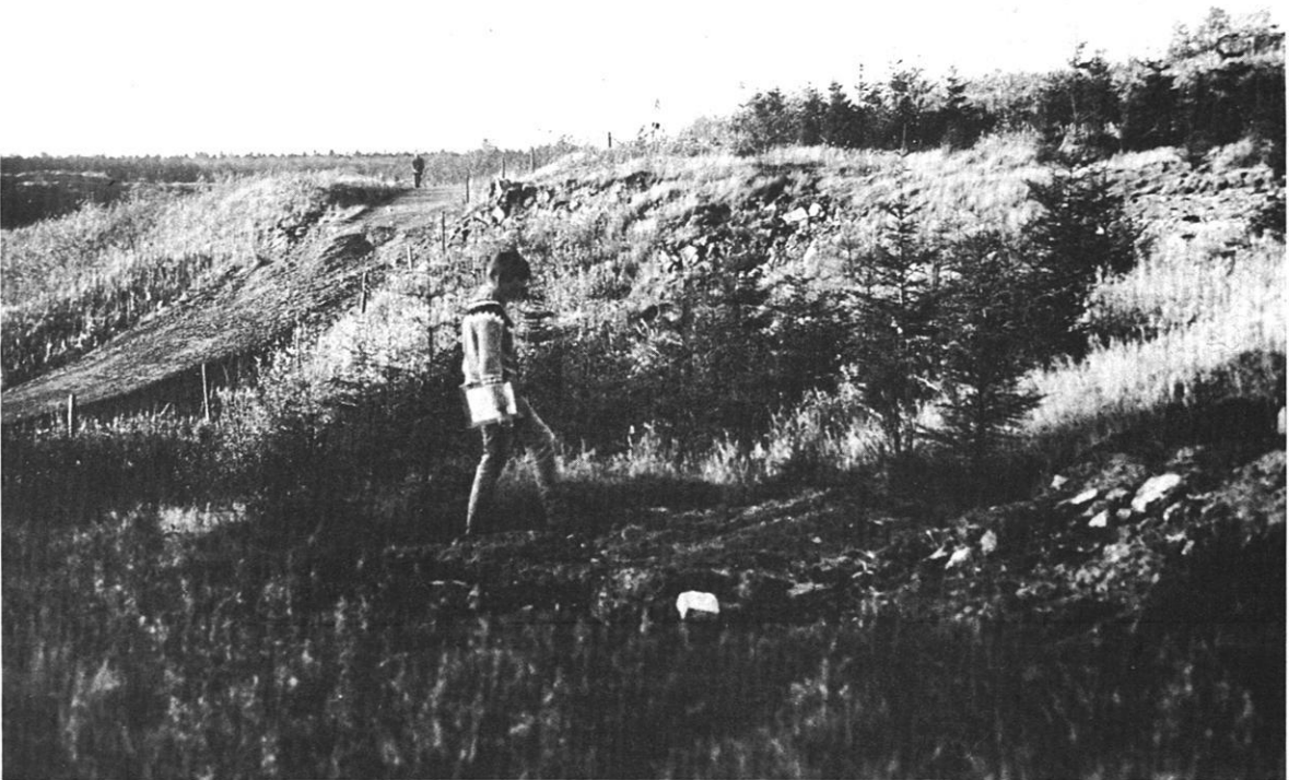
Abb. 4: Die Rutschung im Bermengelände des Innenkippenbereichs.
