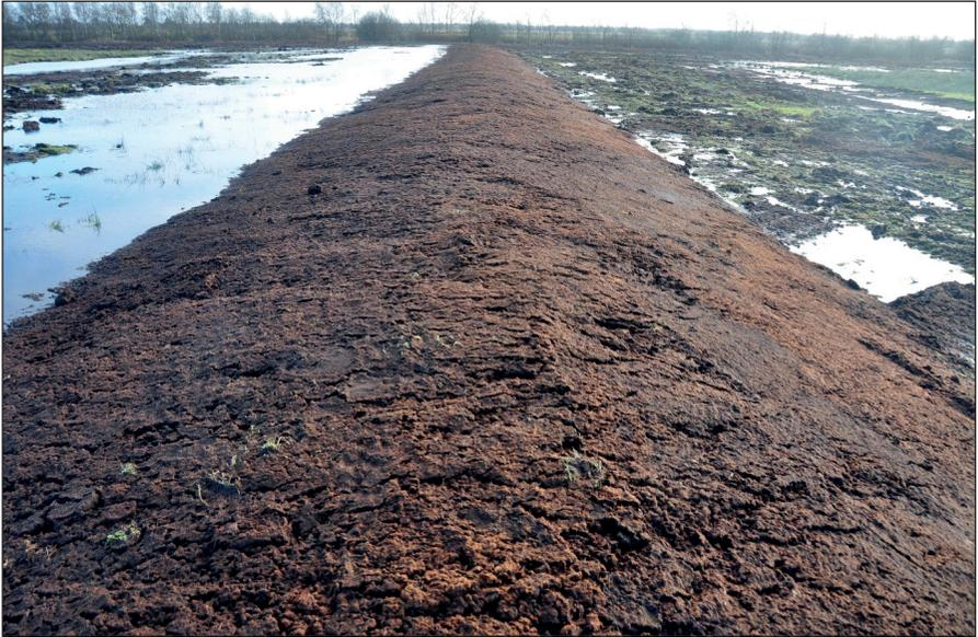
Abb. 3: Stauwirkung einer Verwallung mit Torfdichtwand (Königsmoor, Bau des Walles 2012, Foto von 2013). Die Höhendifferenz zwischen der linken Staufläche nach starker Torfquellung und dem unterhalb liegenden rechten Polder beträgt bis zu 60 cm (Foto: Mordhorst-Bretschneider).
