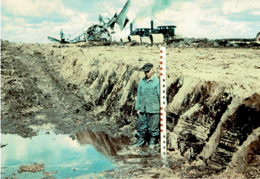
Abb. 8: Ottomeyer Mammutpflug beim Tiefpflügen zur Anlage der Deutschen Sandmischkultur (Quelle: Privatarchiv Dr. Gustav Schünemann, Elisabethfehn). Ottomeyer "Mammut plough" deep ploughs to apply German deep plough cultivation.
