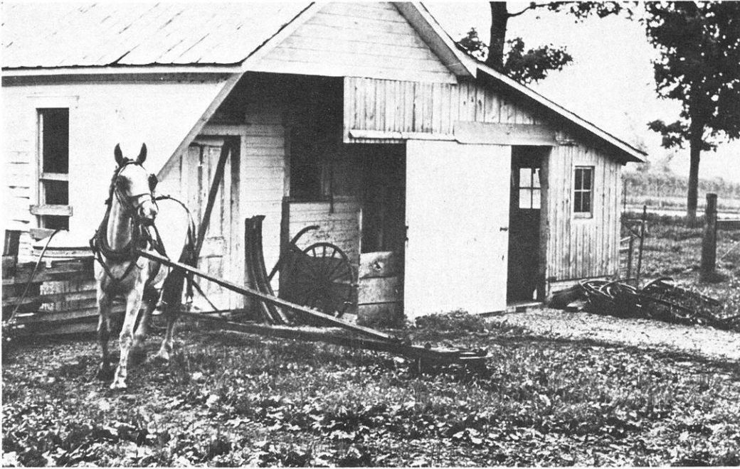
Abb. 9 Amische Sattlerei und Reparaturwerkstatt in Adams County, Indiana. Die benötigten Maschinen werden mittels Kraftübertragung durch zahlreiche Zahnradstangen betrieben, welche durch Pferdekraft in Bewegung gesetzt werden. (Eigene Aufnahme)
