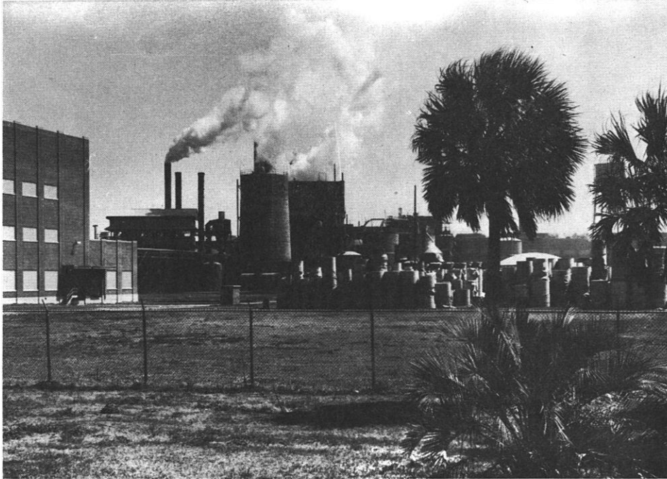
Abb. 21: International Paper Company in Georgetown, South Carolina Im Zentrum des Bildes sieht man vor der technischen Anlage den Kühlturm, im Vordergrund die Lagerung des Endproduktes. (Eigene Aufnahme)
