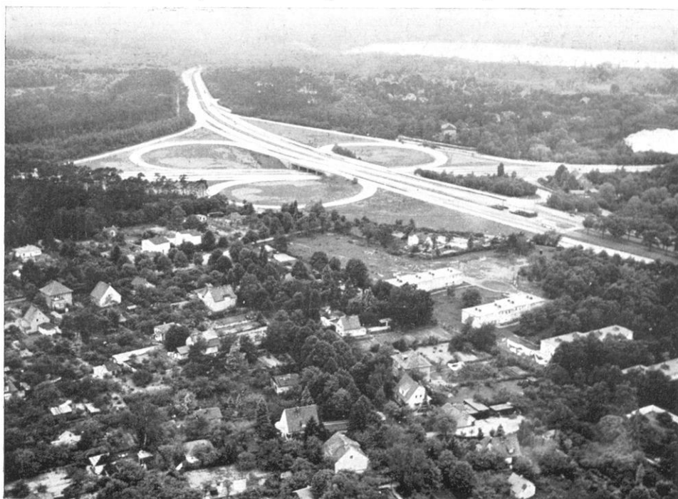
Abb. 6. Das Zehlendorfer Kleeblatt, eine moderne Lösung für einen Autobahnzubringer. Die Hauptverkehrsstraße Berlin—Potsdam (Bundesstraße 1) verläuft dabei über der Autobahn. Das Verkehrsgelände durchschneidet die Villensiedlung Nikolassee (ZK 8), deren jüngster Ausbau am Stadtrand (im Vordergrund) Kleinhäuser und Wohnlauben aufweist. Die Wasserflächen sind der Nikolassee und der Große Wannensee. (Beispiele für ZT 18 b, 18 c, 3 c und 14 a.) — Foto: US-Army
