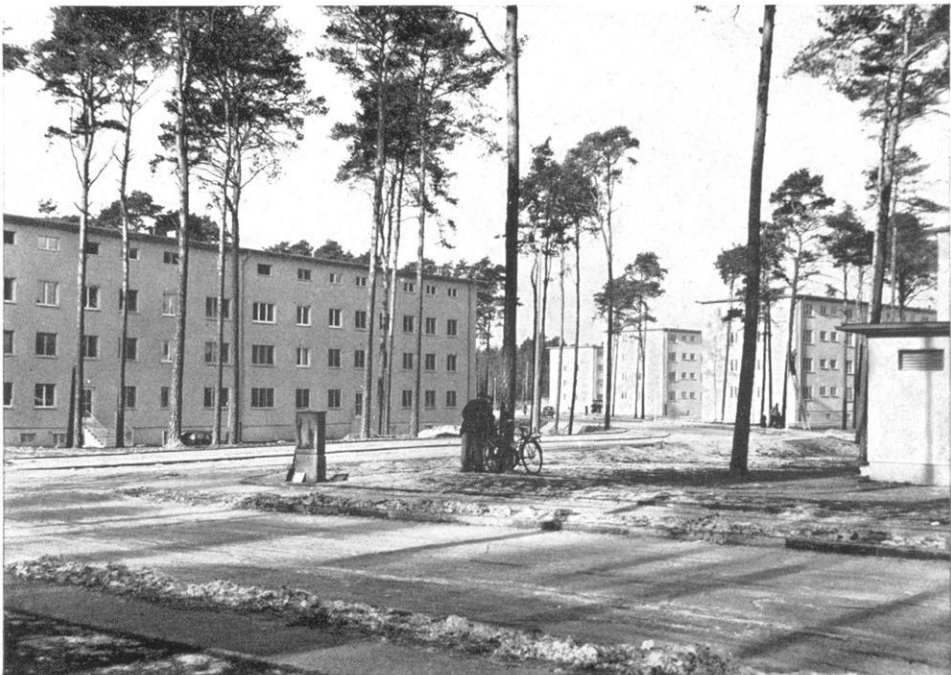
Abb. 2. Mehrfamilien-Reihenhäuser im Zellenkomplex Onkel-Toms-Hütte (ZK 14), der heute die größte Einwohnerzahl Zehlendorfs besitzt. Seit 1926 wurde der Grunewald durch diesen neuen Stadtteil zurückgedrängt, wobei der Baumbestand teilweise erhalten blieb. (Beispiel für ZT 2 b.) — Foto: Landesbildstelle Berlin. (Veröffentlichungsrecht Nr. AZ 7833)
