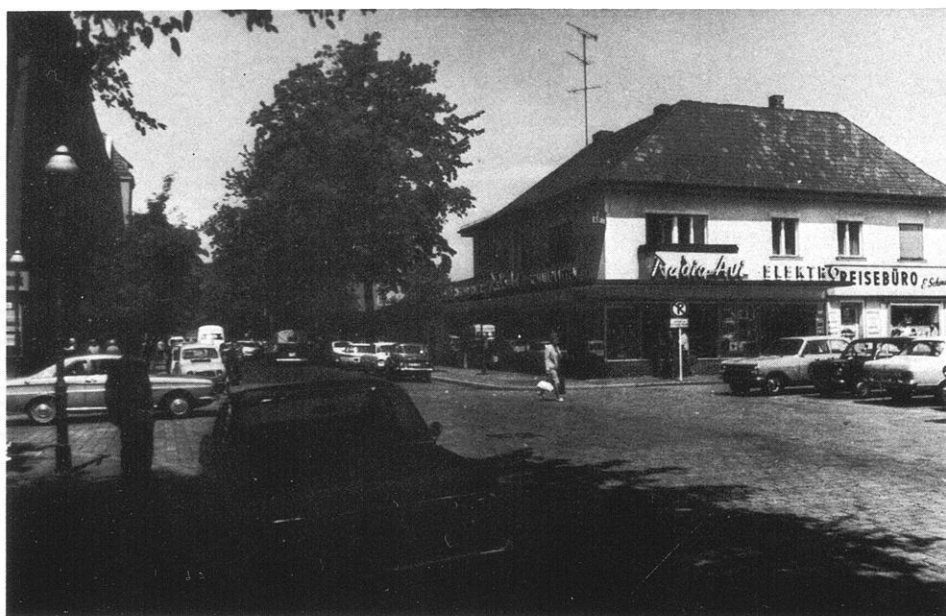
Bild 32 (Mai 1969). Blick in Richtung N über den Vorplatz des S-Bahnhofs Tegel auf die Buddestraße. Die Ladenzeile auf der E-Seite (rechts im Bild) entspricht denen der Gorkistraße. In den viergeschossigen Altbauten auf der W-Seite ist die Reihe der Geschäfte lückenhaft.
