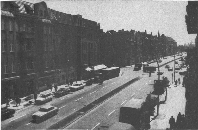
Bild 26 (Mai 1969). Blick nach S auf die Berliner Straße zwischen Grußdorf- und Veitstraße. Bei dem viergeschossigen Altbaubestand ist ebenfalls eine lückenlose Folge von Geschäften im Erdgeschoß zu beobachten. Die darüberliegenden Geschosse sind fast ausschließlich bewohnt. Die Geschäftstätigkeit nimmt nach S hin ab, was sich deutlich an der unterschiedlichen Fußgängerdichte (vgl. Bild 25) ablesen läßt.
