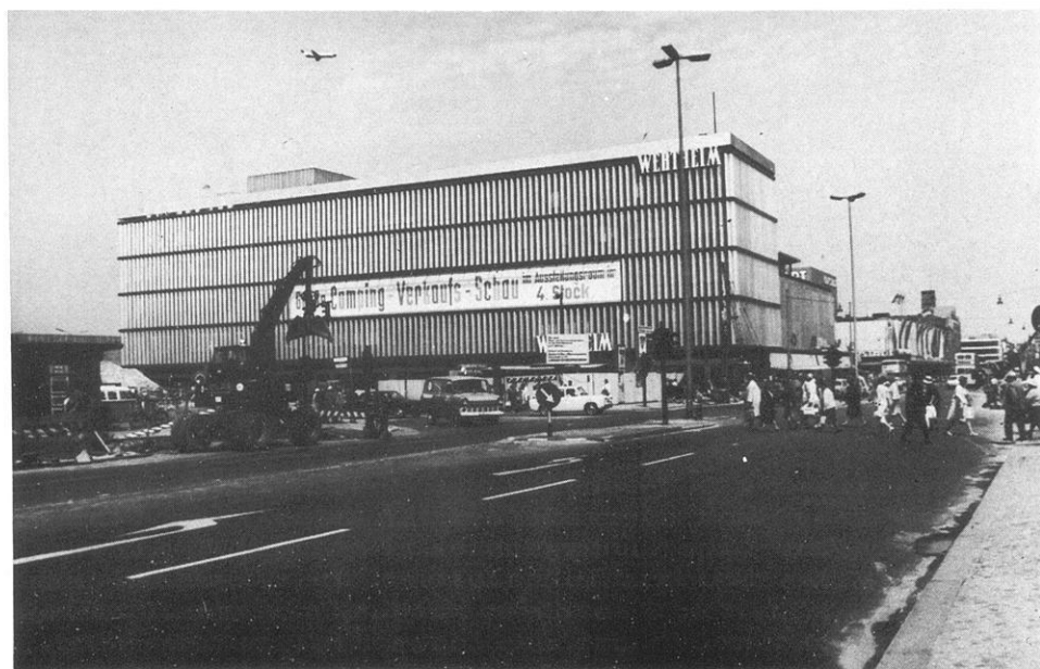
Bild 8 (Mai 1969). Schloßstraße Ecke Schildhornstraße. Nach dem Abriß der auf Bild 7 abgebildeten Häuser wurde das Warenhaus zum Eckhaus. Es konnte seine Schaufensterfront erheblich vergrößern.
