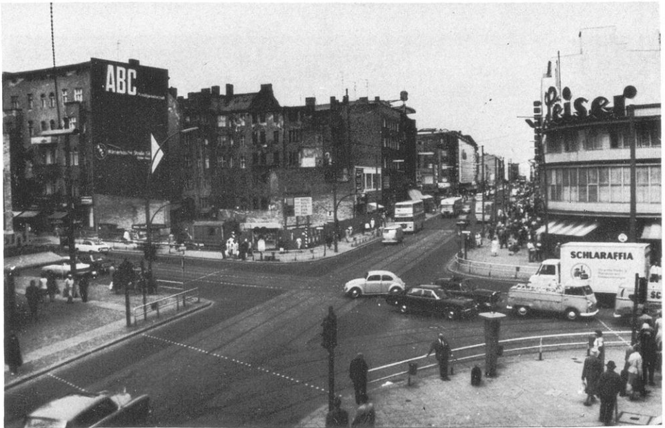
Bild 16 (Juni 1969). Kantstraße Ecke Wilmsdorfer Straße, Blick nach NW. 1969 erfolgte der Abriß der eingeschossigen Bauten (siehe Bild 15). Es ist geplant, ein mehrgeschossiges Büro- und Geschäftshaus zu errichten. Die im Mittelgrund erkennbaren Hinterhäuser sind als Teilruine erhalten geblieben. Die unterschiedliche Intensität der Geschäftstätigkeit auf der W- und der E-Seite der Wilmsdorfer Straße wird eindrucksvoll durch die Dichte des Fußgängerstromes widergespiegelt.
