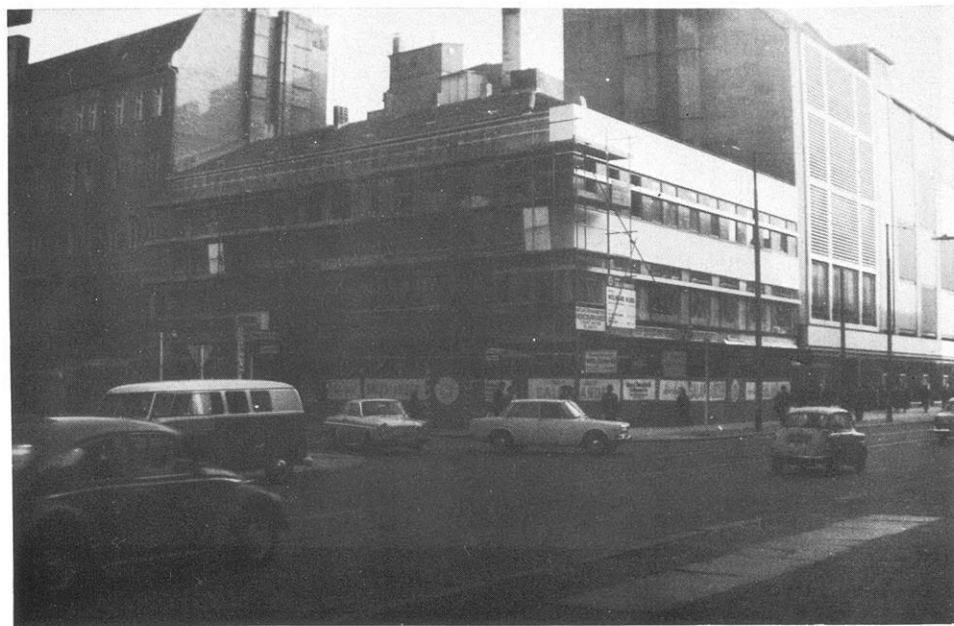
Bild 24 (Oktober 1966). Wilmersdorfer Straße Ecke Goethestraße. Umbau und Modernisierung eines dreigeschossigen Altbaus. Durch die Neugestaltung der Fassade erhält das Haus ein Aussehen, das dem der modernen Geschäftsneubauten gleicht.
