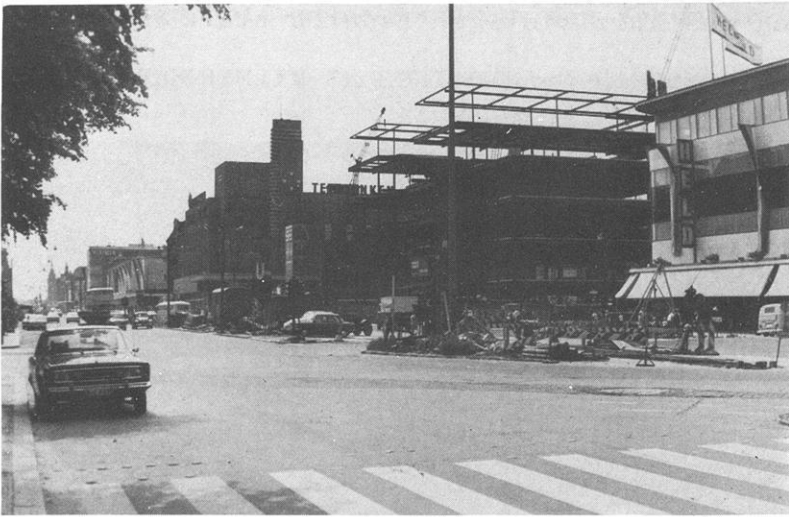
Bild 10 (Mai 1969). Blick über den Walther-Schreiber-Platz in Richtung SW auf die NW-Seite der Schloßstraße. Neben dem viergeschossigen Warenhaus (rechts im Vordergrund) wird auf der vormals durch einen Wochenmarkt genutzten Fläche und auf weiteren Teilen dieses Baublocks ein Neubau errichtet ("Forum Steglitz"). Dieser soll nach seiner Fertigstellung eine Markthalle, Läden, Restaurants, Büros, eine Kegelbahn, Garagen, eine Tankstelle und eine Autowaschanlage aufnehmen. Im Mittelgrund schließt sich der Titaniapalast an, der nach dem Kriege als Kino, Theater, Veranstaltungsraum und Operettentheater genutzt wurde und heute leersteht. Im Hintergrund werden zwei große Warenhäuser und in größerer Entfernung der Turm des Rathauses Steglitz sichtbar.
