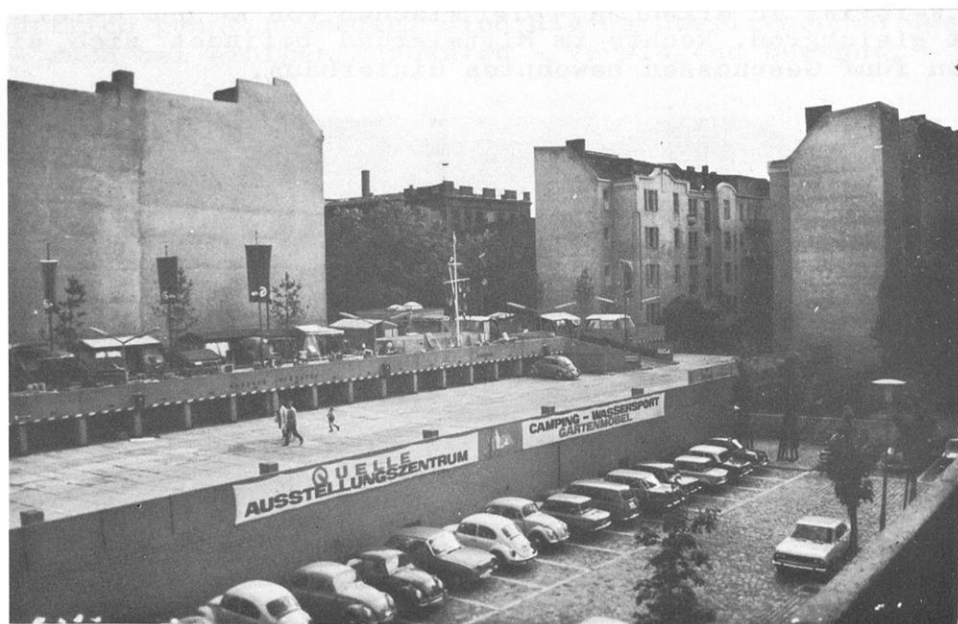
Bild 22 (Mai 1969). Blick nach SW in den E-Teil des Goetheparks. Auf der durch den Abriß der Wohnbauten (vgl. Bild 21) freigewordenen Fläche wurde ein dreigeschossiges Parkhaus errichtet, dessen oberes Dachgeschoß als Ausstellungsfläche dient. Links dahinter schließt sich die Rückfront eines von Kleinindustrie genutzten Gebäudes an, rechts werden die Wohnbauten des W-Teiles des Goetheparks sichtbar. Im Hintergrund ist der Bau der Helen-Keller-Schule zu erkennen.
