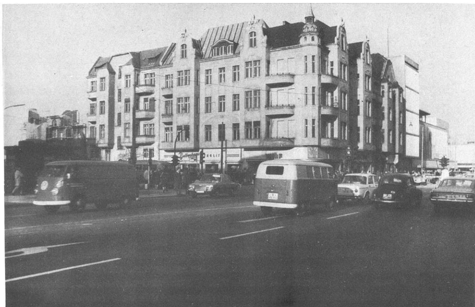
Bild 7 (November 1967). Schloßstraße Ecke Schildhornstraße. Die Häuser auf der NE-Seite der Schildhornstraße fallen dem Bau eines Autobahnanschlusses (Breitenbachplatz-Steglitzer Kreuz) zum Opfer. Hiervon sind auch die im Mittelgrund abgebildeten Wohnhäuser mit den Geschäften im Erdgeschoß betroffen.
