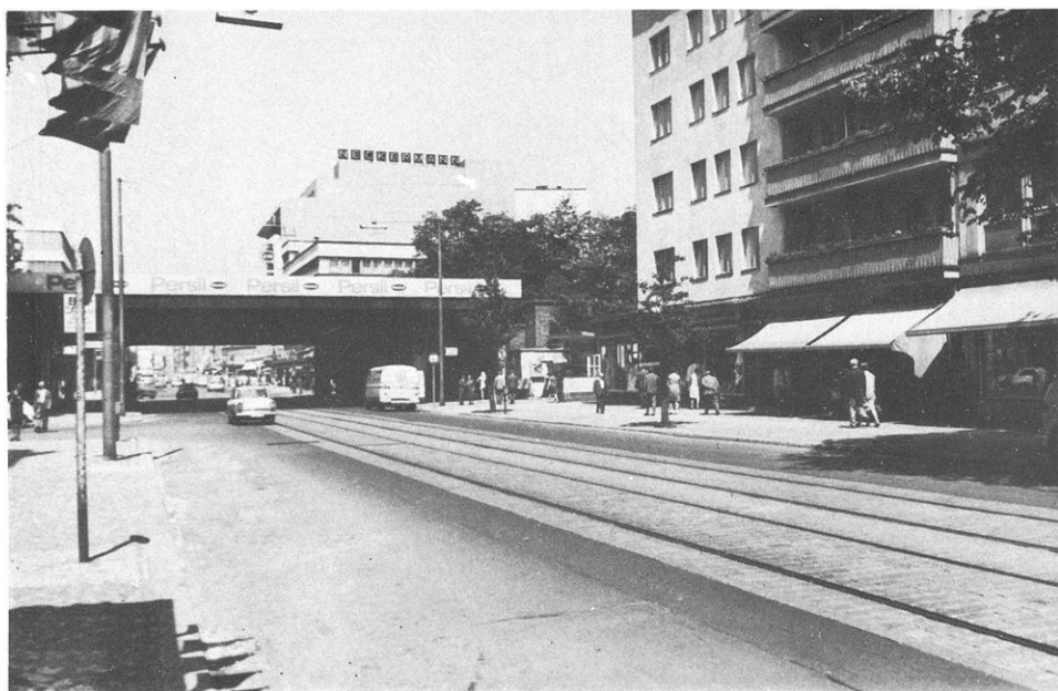
Bild 14 (Juni 1969). Blick auf die S- und Fernbahnbrücke und die E-Seite der Wilmsdorfer Straße. In dem sechsgeschossigen Neubau (rechts im Bild) liegen nur im Erdgeschoß Geschäfte, die oberen Geschosse werden bewohnt. Die Nutzung entspricht damit der der umgebenden Altbauten. Der Bahnkörper hat trotz der Brücke (35 m Straße werden überbrückt) eine starke trennende Wirkung; er ist die südliche Begrenzung des Kerngebietes des Sekundärzentrums.
