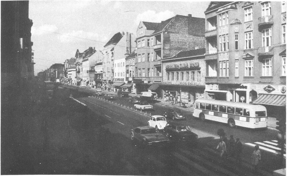
Bild 4 (Mai 1969). SE-Seite der Schloßstraße, vom Rathaus Steglitz aus in Richtung NE gesehen. Hier ist vorwiegend alter Baubestand anzutreffen, die Häuser sind zwei- bis viergeschossig, z.T. ist das Dachgeschoß ausgebaut worden. Alle Erdgeschosse werden gewerblich genutzt. In einigen Fällen ist die gesamte Fassade der Häuser neugestaltet worden (z.B. am 2., 5. und 7. Haus von rechts). Die oberen Geschosse der Häuser im Mittelgrund werden bewohnt.
