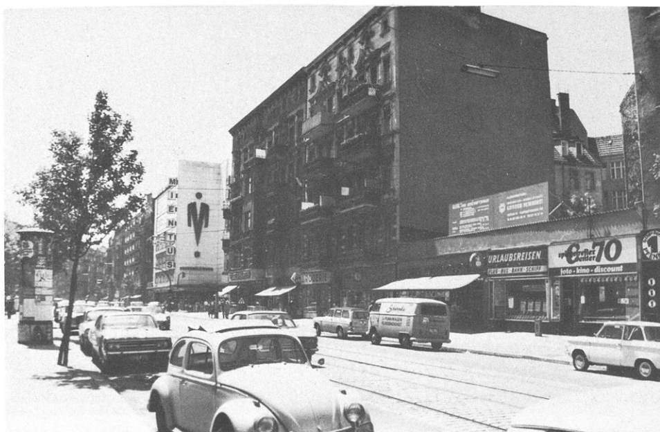
Bild 13 (Juni 1969). W-Seite der Wilmsdorfer Straße im Bereich des südlichen Geschäftsschwerpunktes des Sekundärzentrums.
