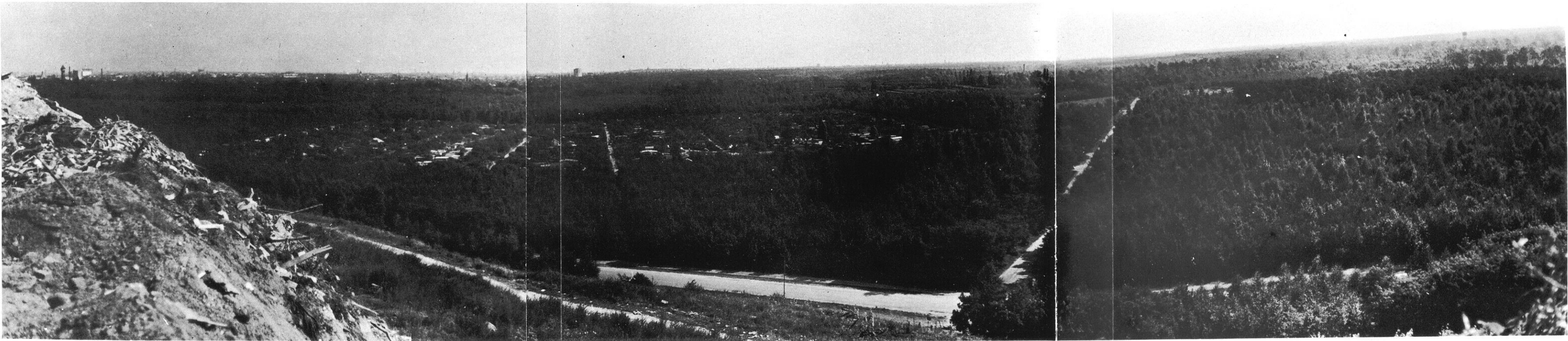
Bild 3oa: Blick von der Trümmerschüttung Teufelsberg nach Osten bis Südosten (August 1966).
