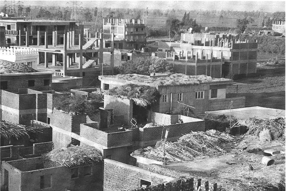
Photo 32: Intensive Neubautätigkeit am Rand von Sibrbay. Die in Betonständerbauweise errichteten Häuser bleiben z.T. jahrelang halbfertig.
