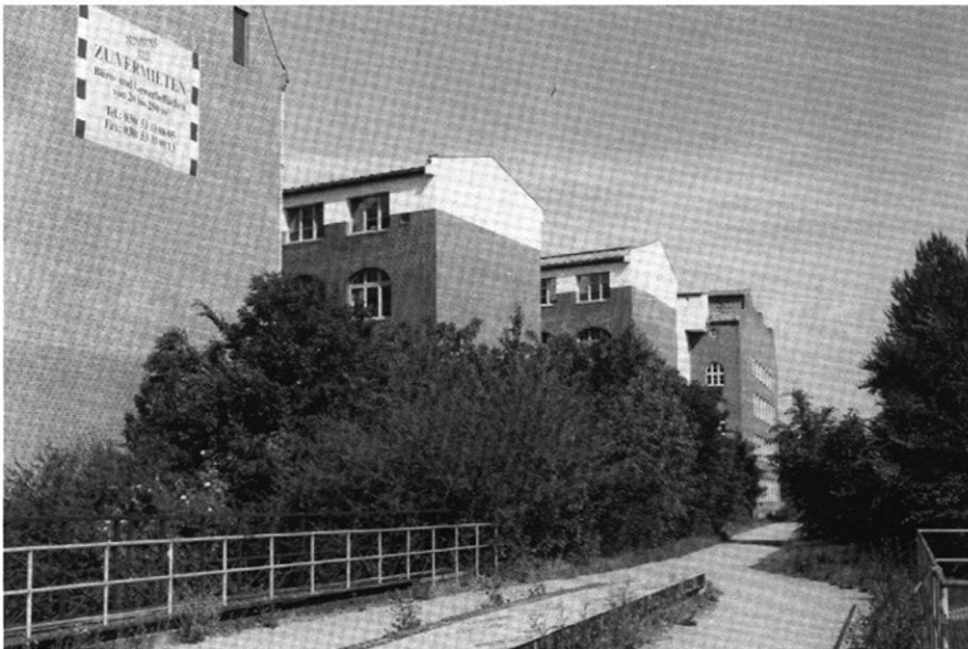
Foto 10: Sanierte Industriegebäude in der Jordanstraße, Treptow
