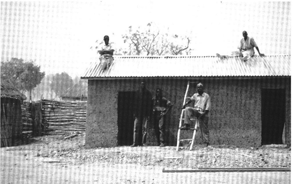
Foto 6: Anbau des Hauses der Fulbehirte
