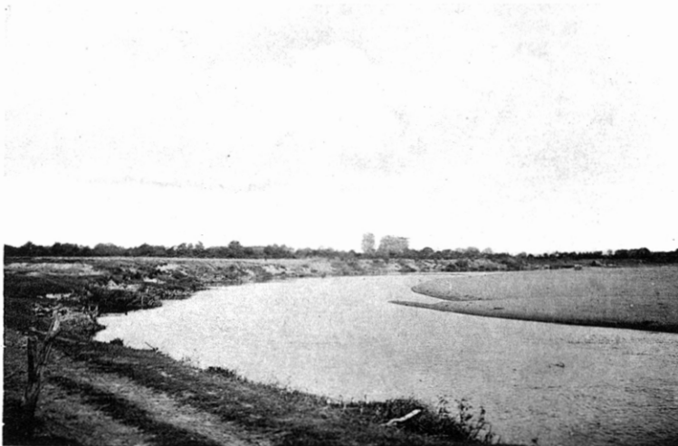
Abbruch und Anschwemmung der Ems.
