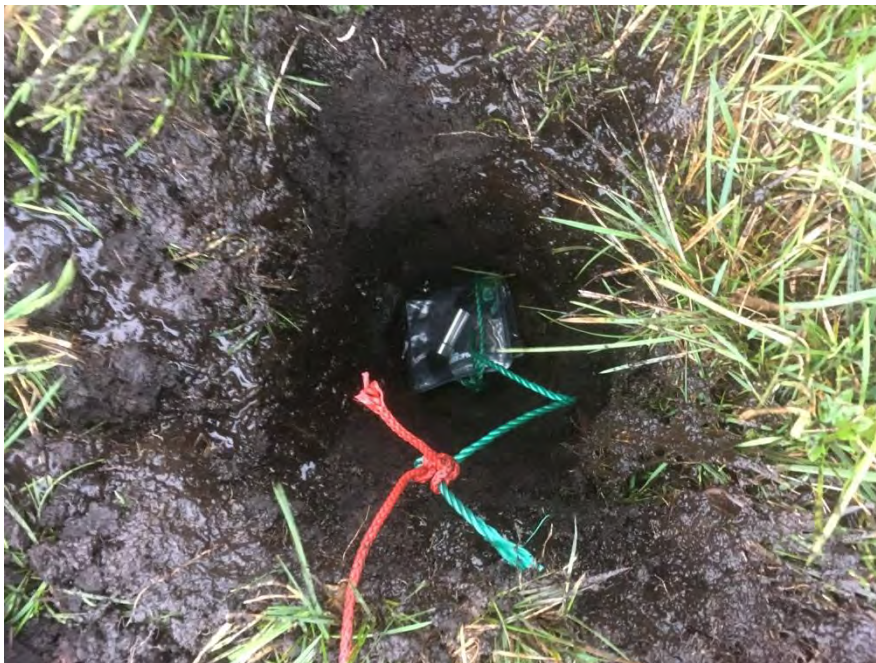
Abbildung 35: Einsetzen eines Datalogger an der Oberkante der Mudden
