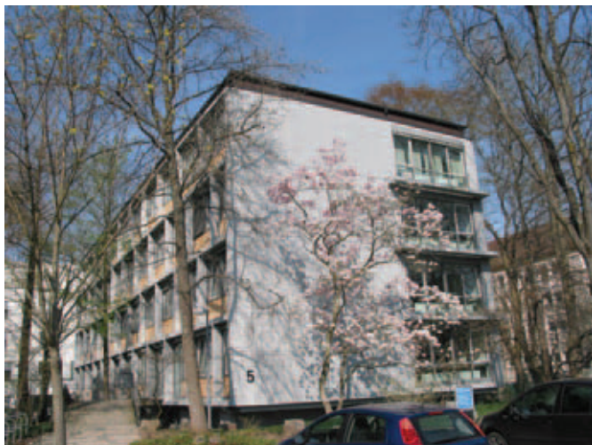
Abb. 2: Regierungspräsidium Freiburg, Landesamt für Geologie, Rohstoffe und Bergbau, Dienstgebäude Albertstraße 5
