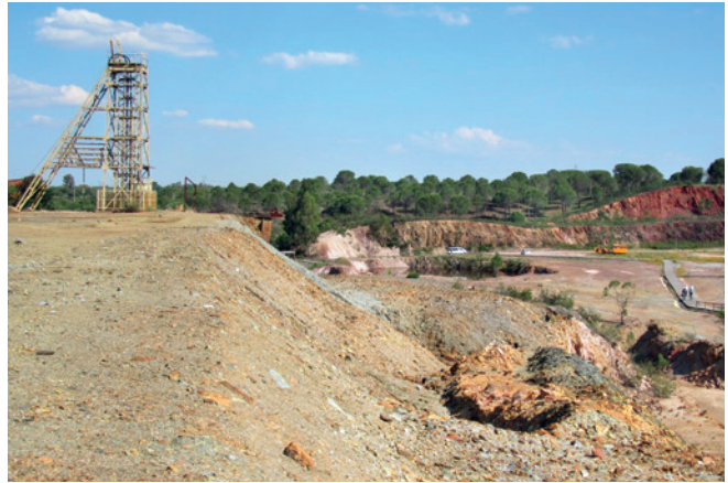
Abb. 1. Fördergerüst des ehemaligen Pyrit-Bergwerks Lousal, umgeben von Halden, Bergteichen und kontaminiertem Gelände
