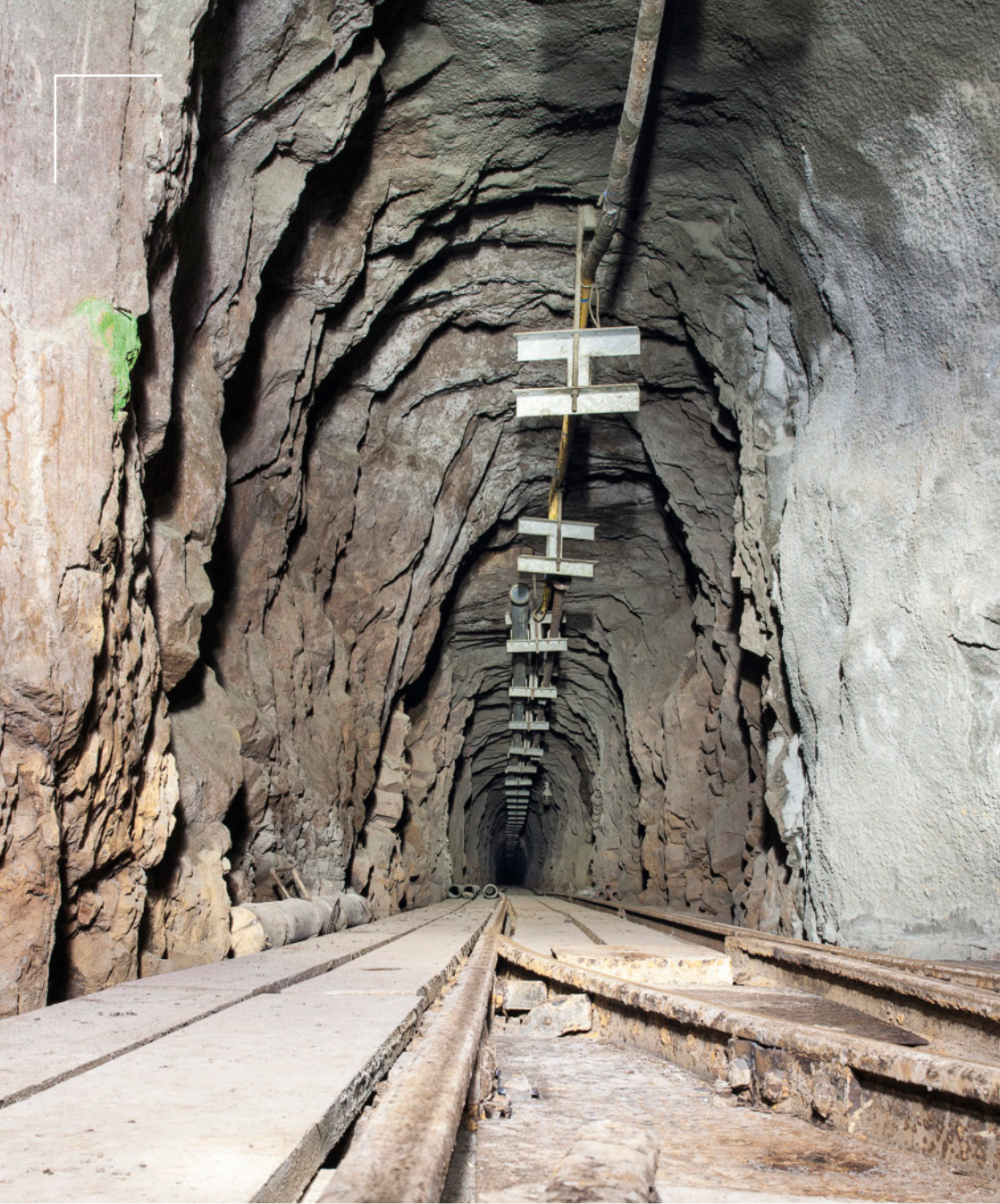
Tiefer Elbstolln — ein bedeutendes bergtechnisches Wasserhaltungsbauwerk. Der Tiefe Elbstolln dient der Ableitung von Grubenwässern aus dem Döhlener Becken in die Elbe. Vorgetrieben von 1817 bis 1836, verläuft er auf einer Länge von fast 6 km geradlinig von Freital-Zauckerode nach Dresden-Briesnitz, um dort in die Elbe zu entwässern. Die Aufnahme vermittelt die Situation im Potschappel-Wilsdruff-Porphyr, etwa 5,8 km vom Mundloch entfernt, nahe des 2012 geschaffenen Durchschlages zum sogenannten Wismutstolln. Mit letzterem sind nun alle Grubengebäude des Freitaler Steinkohlengebietes hydraulisch an den Tiefen Elbstolln angeschlossen (Foto: Jan-Michael Lange).
