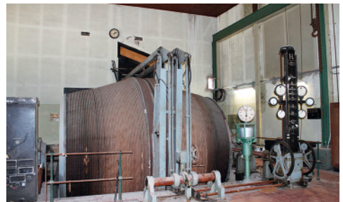
Abb. 5: Konische Trommel, die „Leibniz-Trommel“, im Achenbach-Schacht Bad Grund (Foto: W. Lampe)
