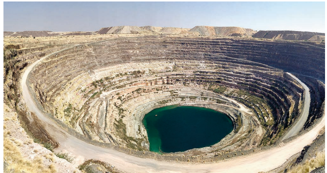
Stillgelegter Pit DK1 der Letlhakane-Diamantenmine in Zentralbotswana (Durchmesser: 1 km, 350 m tief; ~ 27 Karat pro 100 t Gestein). Derzeit laufen Evaluierungen, welche einen Abbau untertage in Betracht ziehen.
