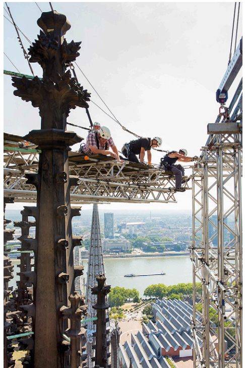
Gerüstbau Kölner Dom, Nordturm, 22.7.2013 (Foto: M. Unkelbach)
