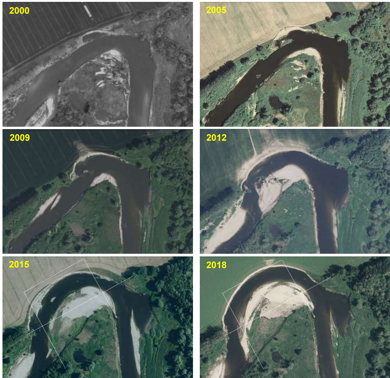
Abbildung 3: Verlagerungstendenz im gesicherten Prallufer bei Laußig, z.T. mit Hilfslinien zum Vergleich. Quelle: GeoSN, Datenlizenz siehe [3], ergänzt.
