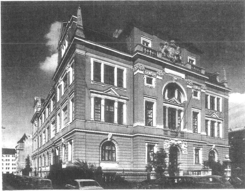
Abb. 4: Ehemaliges Institutsgebäude (1950-1971) in der Richard-Wagner-Straße 10 in München (VIDAL 1994).
