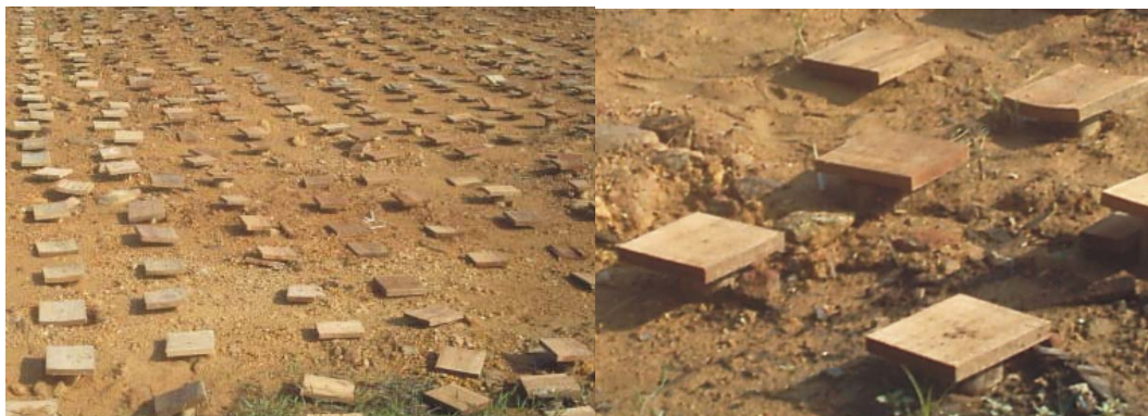
Fig. 1-4. Mini Pile with Mini Board Cap
