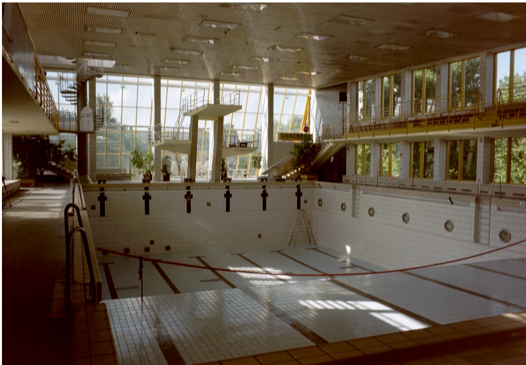
Foto 19: Das Hauptbecken des Hallenbades während der Sommerpause. Eigenes Foto
