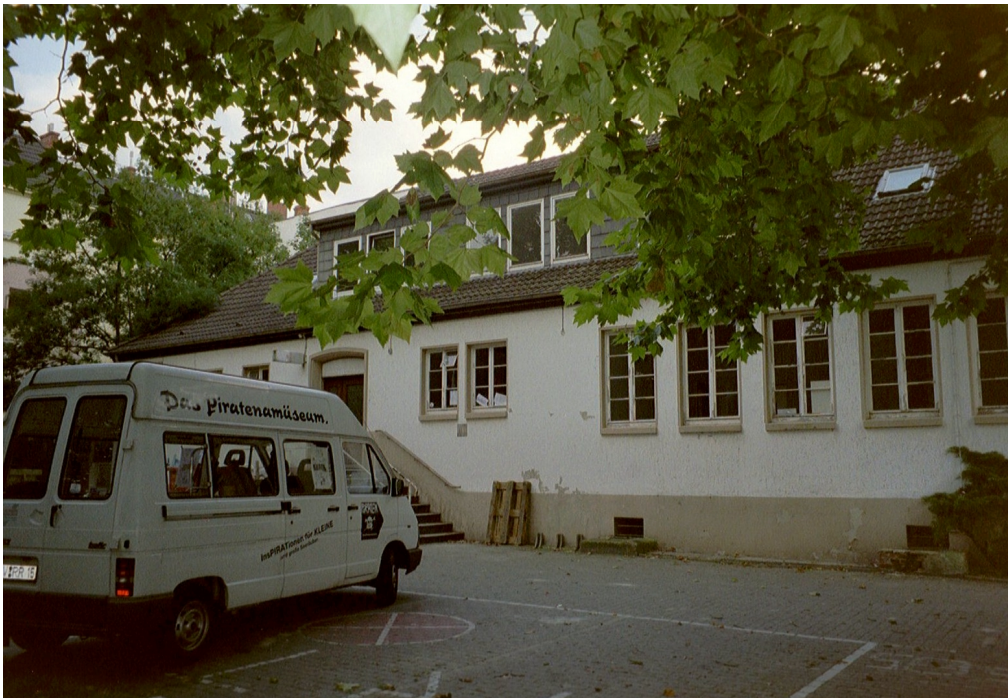
Foto 4: Das Jugendgästehaus „Piratennest“ während der Renovierungsphase. Eigenes Foto
