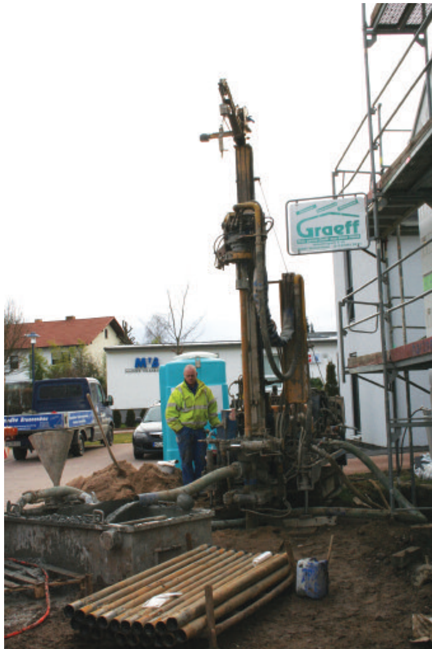
Abb. 2: Bohrgerät bei der Herstellung einer Bohrung.
