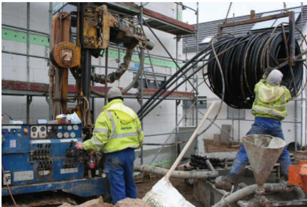
Abb. 4: Einbringen einer Erdwärmesonde in das vorbereitete Bohrloch.
