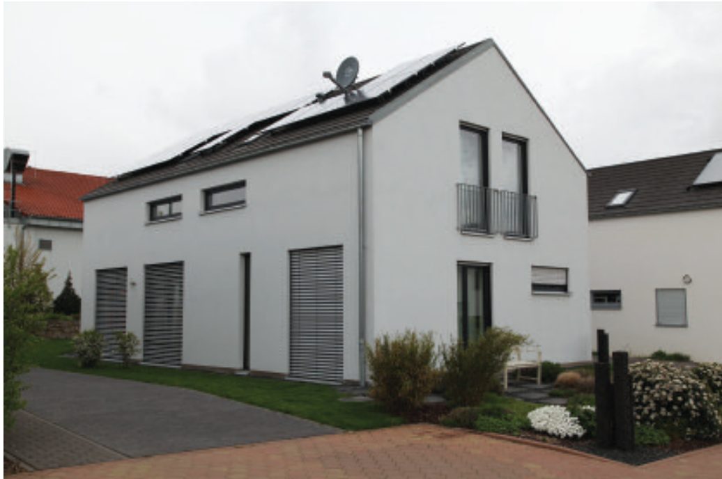
Abb. 8: Gesamtansicht des Objektes mit Fotovoltaik-Anlage auf der nach Süden orientierten Hälfte des Satteldaches (Aufnahme 4/2016).
