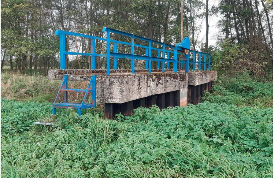
Abb. 4: Kleinstauanlage mit Stahlspundwand, Hubschütz und Zahnstange in der Friedländer Großen Wiese, deren Funktionstüchtigkeit aufgrund von Moorschwind stark eingeschränkt ist. An der Treppe ist das Ausmaß des Moorschwindes zu erkennen (Foto: Irene Kalinin).
