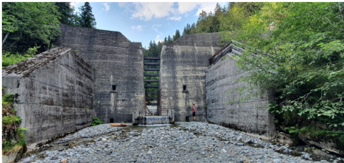
Abb. 36: Murbrecher mit dahinter liegendem Geschieberückhaltebecken. Blickrichtung: N, Koordinaten (Standort Bildaufnahme): 369088,86 236226,94.
