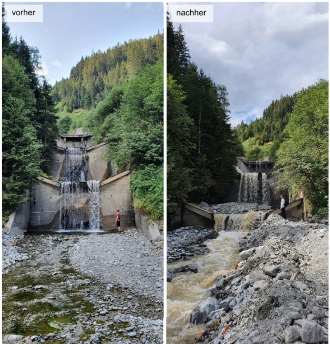
Abb. 38: Sperren 24, 25 und 26 am 25.07.2022 und nach dem Starkniederschlagsereignis am 29.07.2022. Blickrichtung N, Koordinaten (Standort Bildaufnahme): 368967,56 236674,73.
