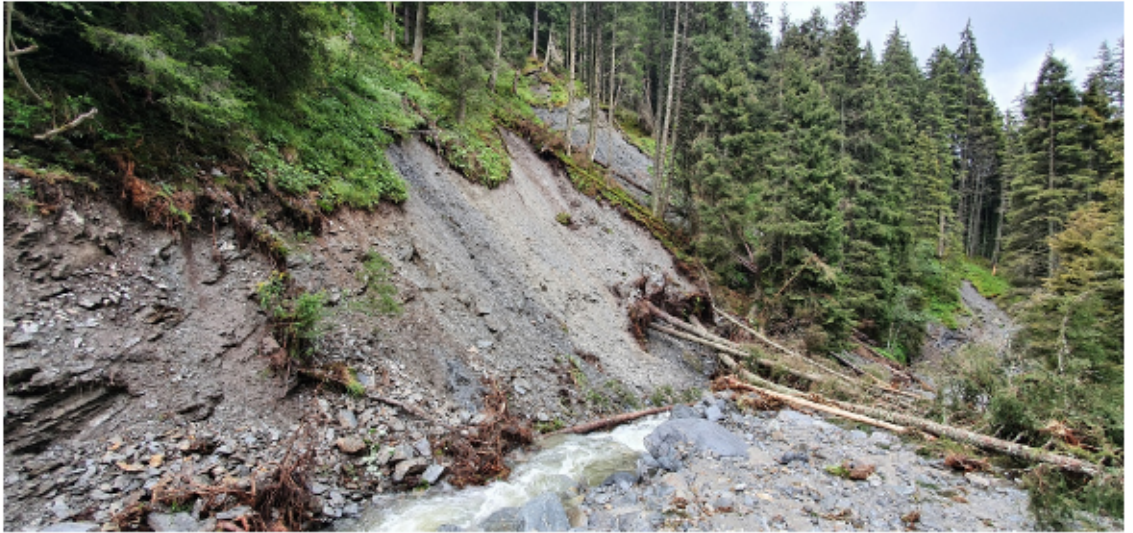
Abb. 37: Durch das Starkniederschlagsereignis verursachter Uferanbruch Nr. 17. Blickrichtung: Se, Koordinaten (Standort Bildaufnahme): 368564,29 238178,77.
