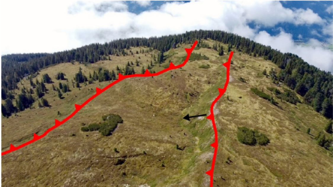
Abb. 21: Abrissstruktur (rot) mit Sackungen in der Gratregion südlich des Trattenbachecks. Blickrichtung: S, Koordinaten (Standort Bildaufnahme): 367116,8 237887,7 (Drohnenaufnahme).
