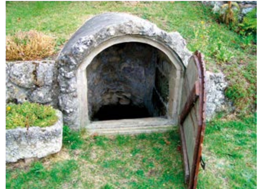
Abb. 8: Die an tektonischen Trennflächen angelegte, in einer Brunnenarchitektur gefasste Quelle des »Herrenbrunnen«. Privatgrundstück 50 m SW' der St. Martin-Kirche in Hohenmirsberg/Ofr.
